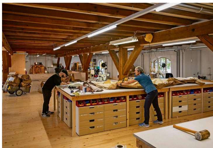
Brandschutz einfach gemacht: Die Bretter an der Unterseite der Längsbalken sollen ein schnelles Abbrennen verhindern.
